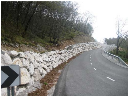
Slika 4 Kamnita zložba od km 6+212 do km6+323
