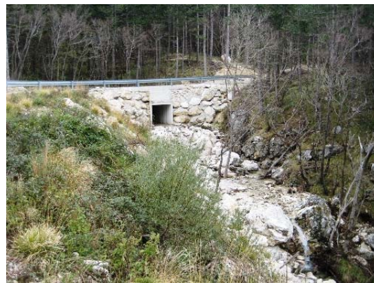
Slika 5 Škatlast prepust na prečkanju potoka Lokavšček
