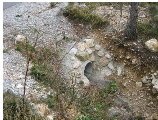
Slika 3 Iztok iz cevnega prepusta DN600
